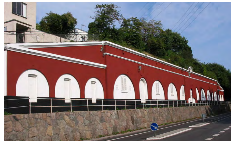
Referencefoto: Beboelseshus på toppen af Christiansholmsfortet, som genanvender og overbygger dele af den tidligere militærstruktur, Arkitekt Mogens Lassen.
